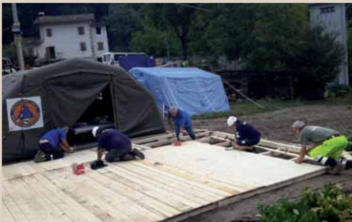
Alcune fasi dell'attività di ricostruzione
