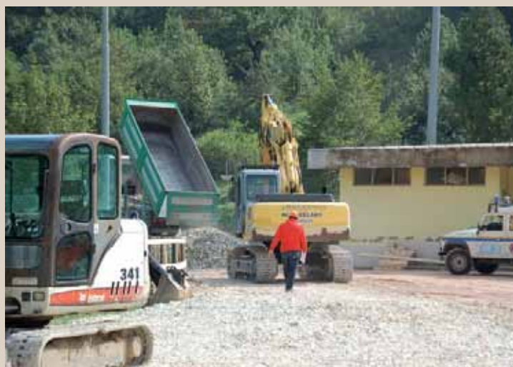
Alcune fasi dell'attività di ricostruzione
