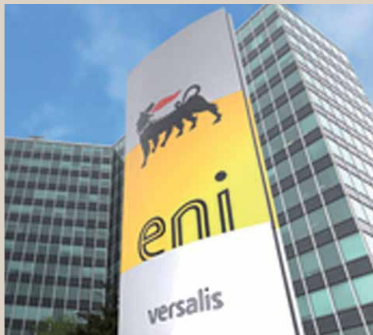
Versalis: uno dei servizi della filiale di Ripalta
